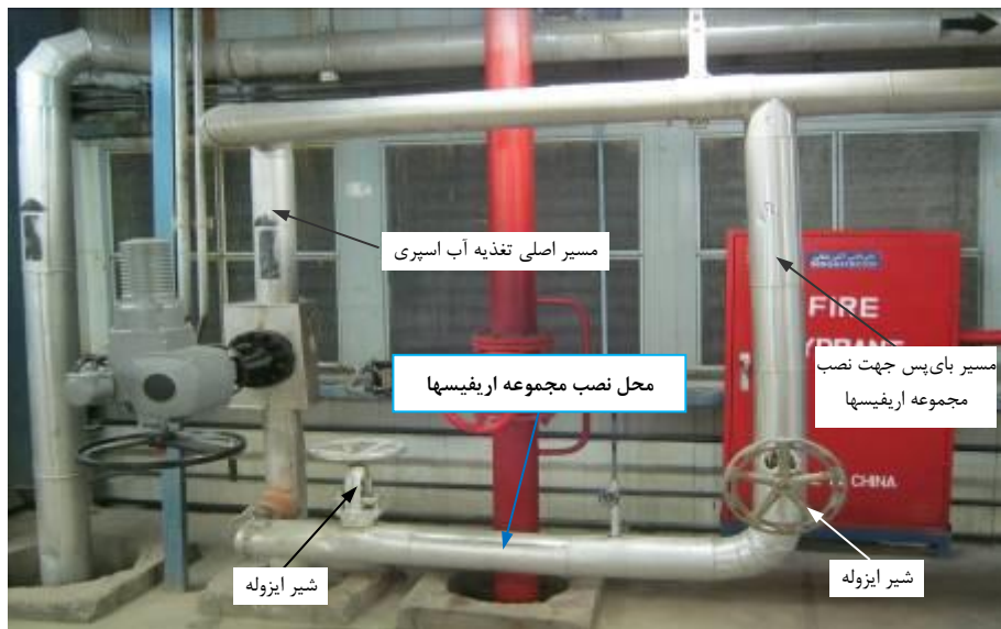
شکل (۶): ایجاد مسیر بای پس بر روی مسیر آب ورودی به هدر اصلی سیستم آب اسپری برای انجام تست تجربی
