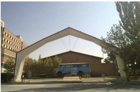
شکل ۱۹- نمونه واقعی سازه کامپوزیتی با صفحات تاشده
